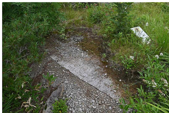
図 3-5-1-20b 敷設から 12 年経過したヤシマ ット
